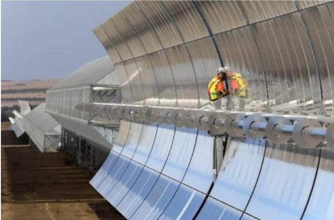
Abb. 42 Teilansicht einer der Parabolorinnen des Solarkraftwerkes Andasol (Quelle: Copyright Fa. Flagsol GmbH in Köln; Reproduktion mit frdl. Genehmigung des Eigentümers)
